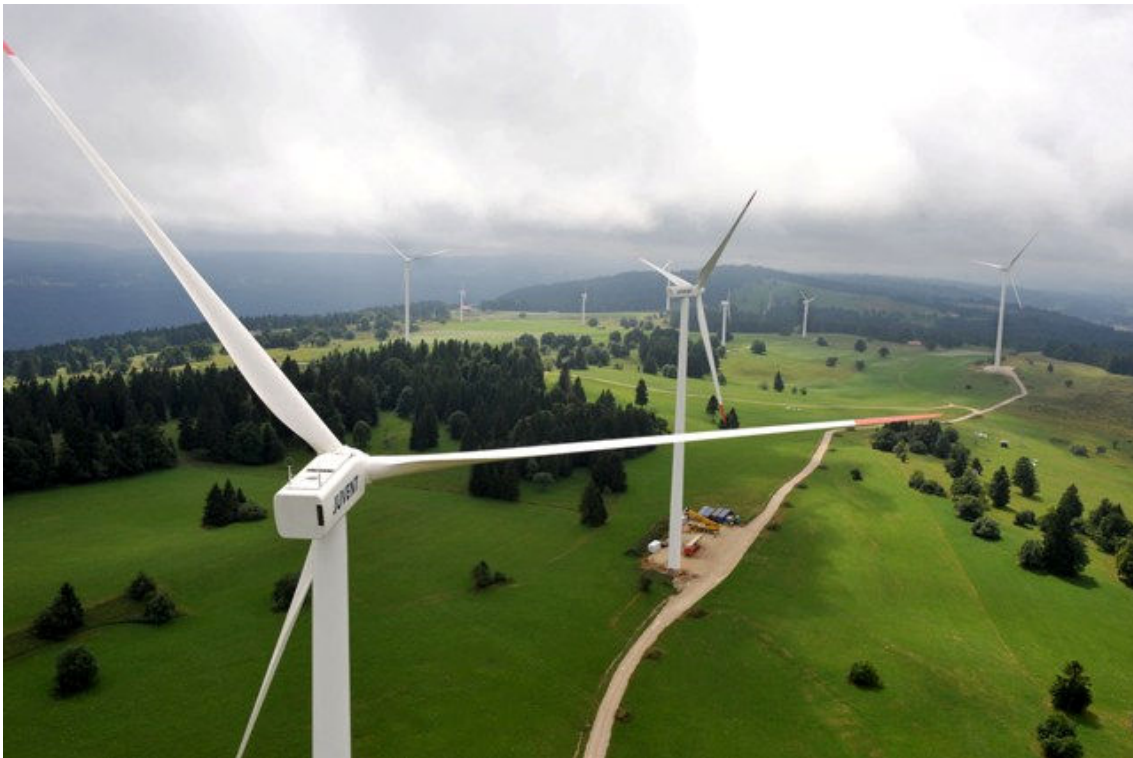
L'extension du parc éolien de Mont-Crosin en phase finale de construction, 29.07.2010, arcinfo.ch
